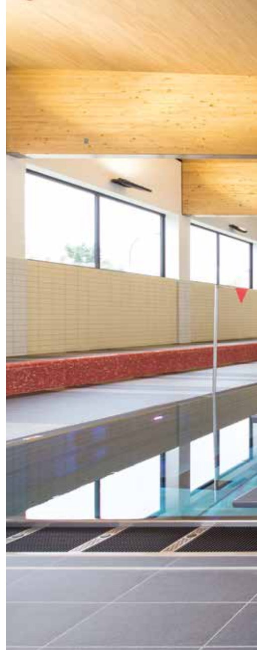
▲ Edelstahlbecken mit Startsockeln ◀ Umkleide mit behindertengerechter Wechselkabine
