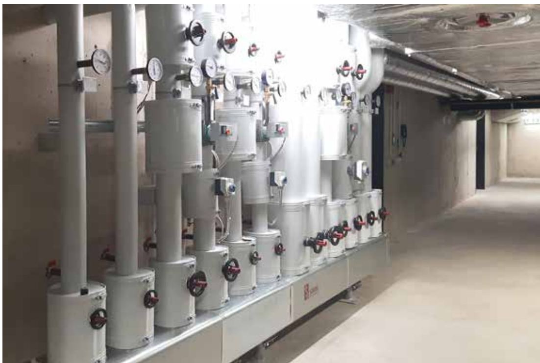
◀ Heizkreisverteiler im Untergeschoss
